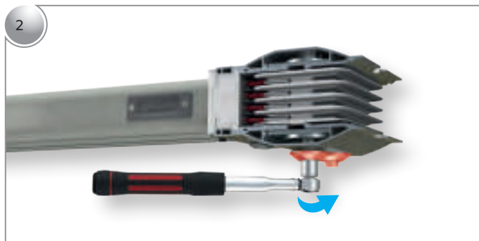
Кришки кріпильних болтів знімаються.
